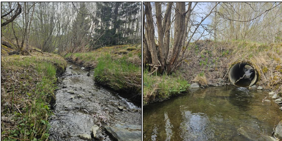
Figur 4-6 Kulvert i Eklesbekken, omtrent 100 m fra utløpet til Nidelva. Ble ikke vurdert som vandringshinder for fisk. Foto: Johanna Skrutvold 08.05.24.
