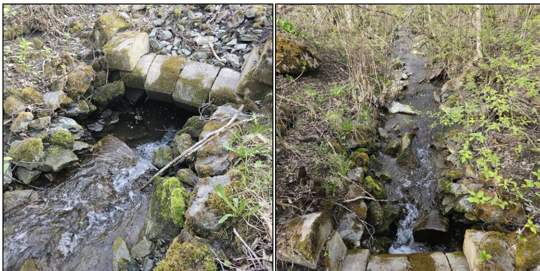
Figur 4-7 Kulvert som kan være mulig vandringshinder, se plassering i figur 4-12. Foto: Johanna Skrutvold 08.05.24.
